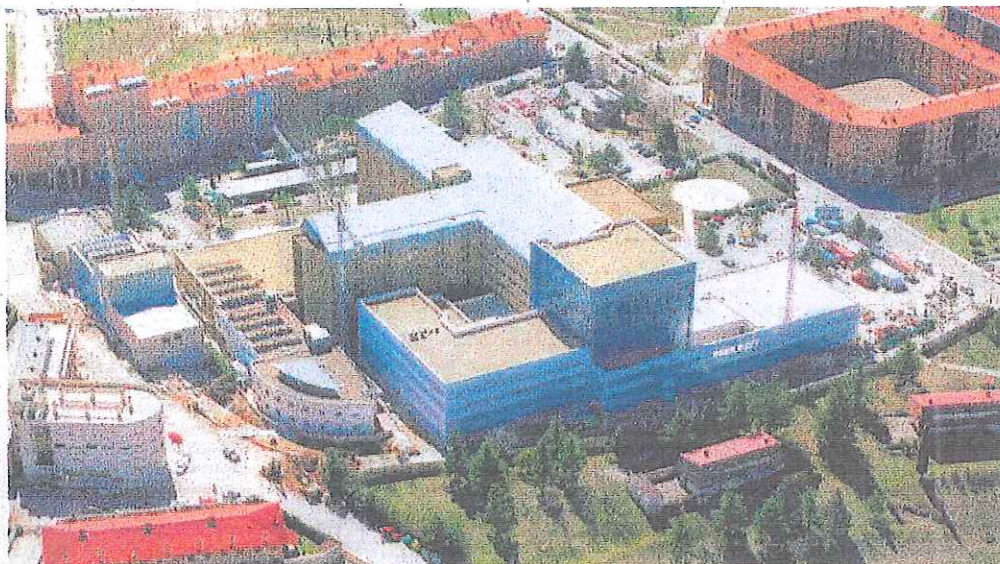
Hospital Santa Bárbara, en Soria.
